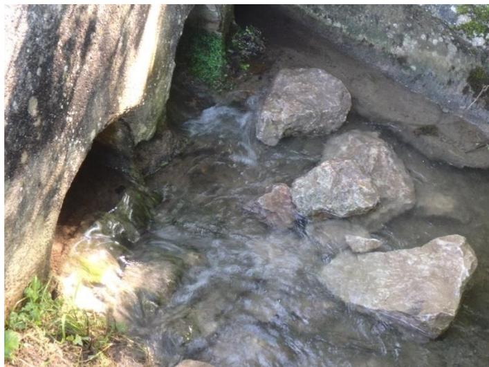
Photo 19 : Apport de blocs dans le ru Coulant en aval d'un ouvrage de franchissement
