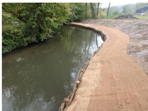
Photo 20: Tressage de saule et protection en géotextile
