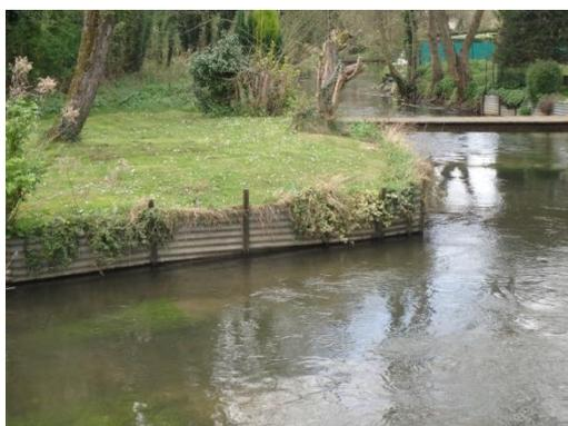
Photo 13 : Protections artificielles en tôles
