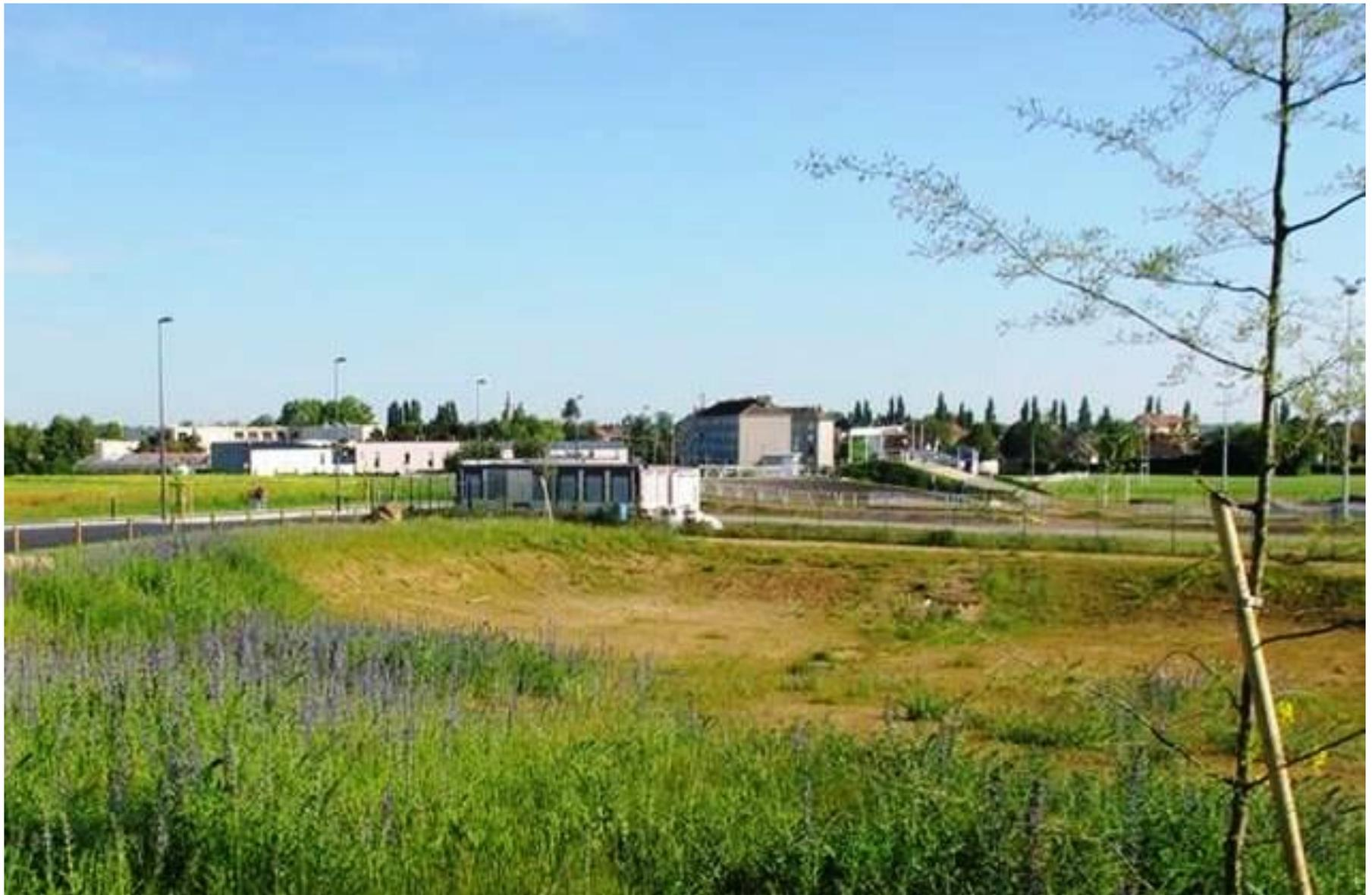
Le bassin d'infiltration a un rôle identique aux noues mais offrent des capacités de rétention et d'infiltration plus importantes.
