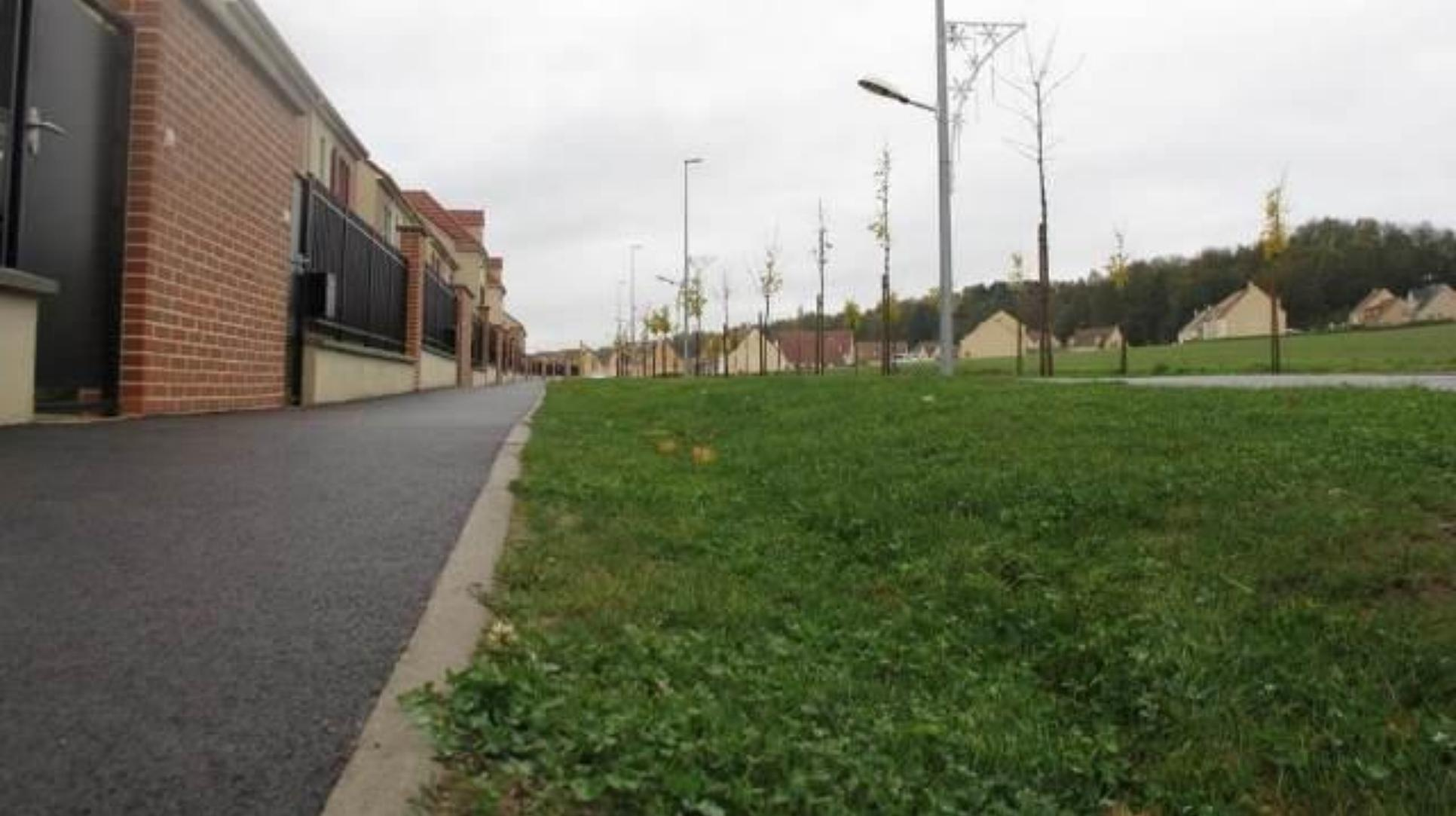
Les noues réduisent la vitesse d'écoulement et favorisent l'infiltration des eaux de surface. Grâce à des profils très doux, elles intègrent l'espace sans rupture nette et peuvent être gérées facilement en tonte ou en fauche.
