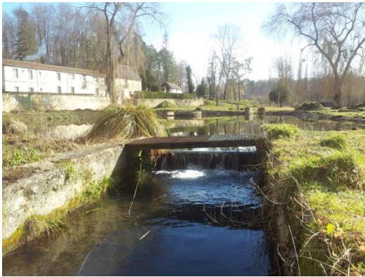
Vue aval de l'ouvrage
