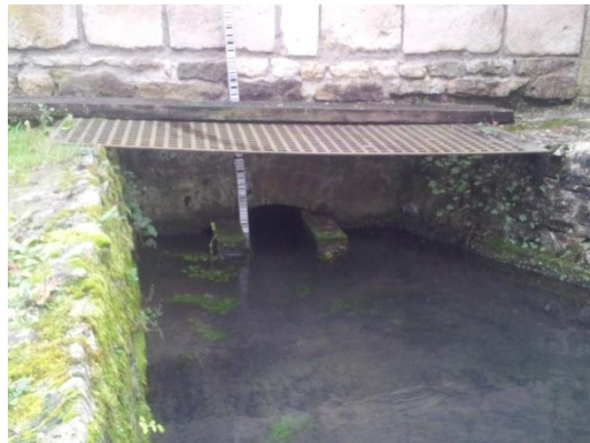
Vue aval de l'ouvrage
