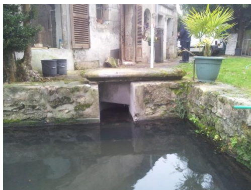
Seuil B : vue amont
