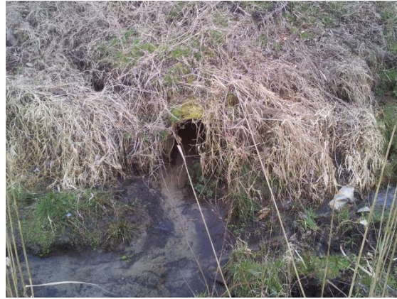
Vue aval de l'ouvrage
