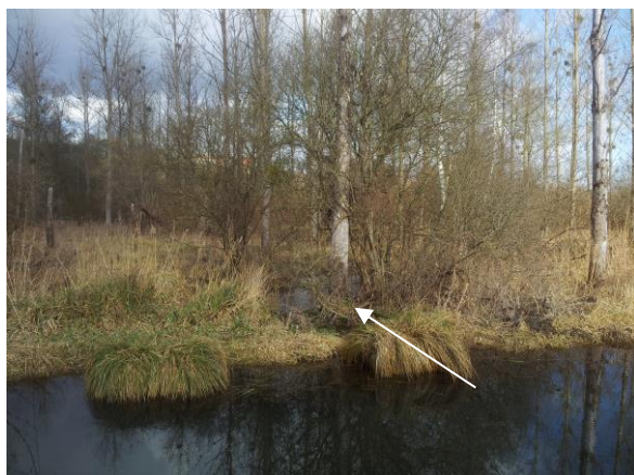
Brèche dans l'ancien bief, passage de la Moise vers l'automne en aval
