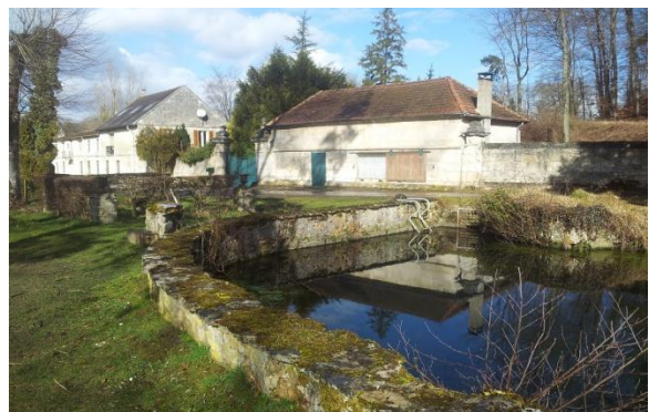
Moise perchée en amont du moulin
