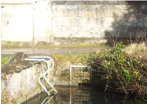
Vue amont de l'ouvrage
