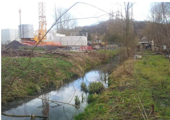
STEP en construction
