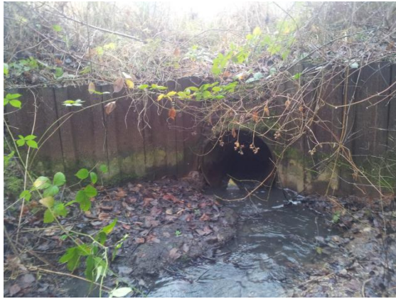
Vue amont de l'ouvrage
