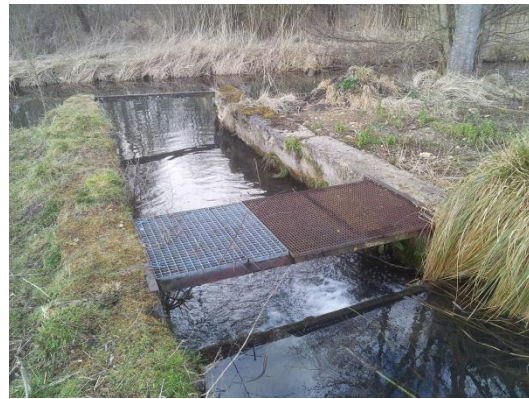
Vue amont de l'ouvrage
