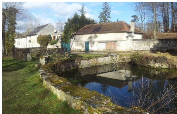
Moise perchée en amont du moulin
