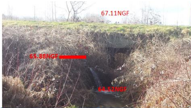
Rejet actuel en amont du pont de la route, Chute = 1.36m
