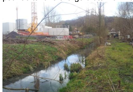
STEP en construction
