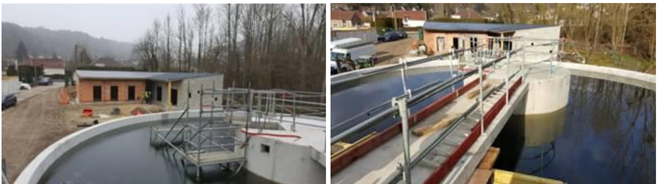
Photo 1: station d'épuration de Béthisy-Saint-Pierre (en cours de construction)
