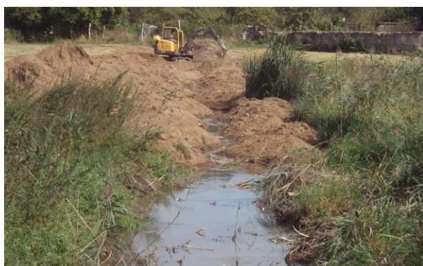
Photo 6: Mise en place de la terre sur le ru de Bonneuil
