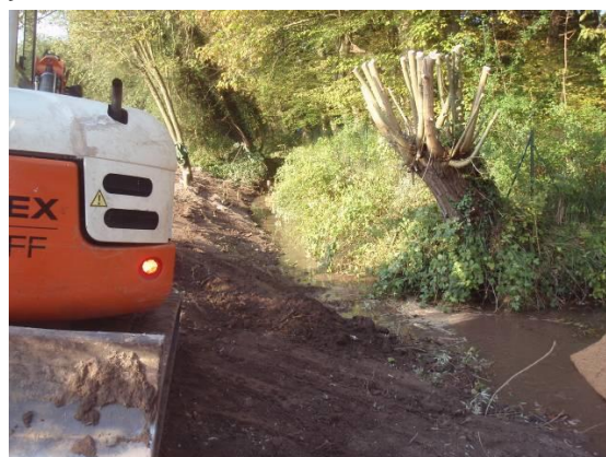
Photo 7: Talutage des berges en pente douce sur le ru de Fond de Vaux
