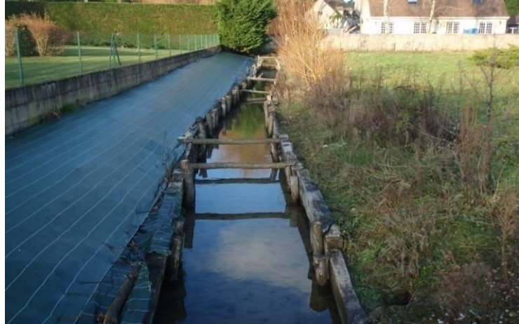
Photo 22: Protections de berge non adaptées sur le ru Ville
