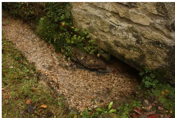
Photo 13 : Lavoir d'Orrouy après l'arasement du seuil et la mise en place de la recharge en cailloux
