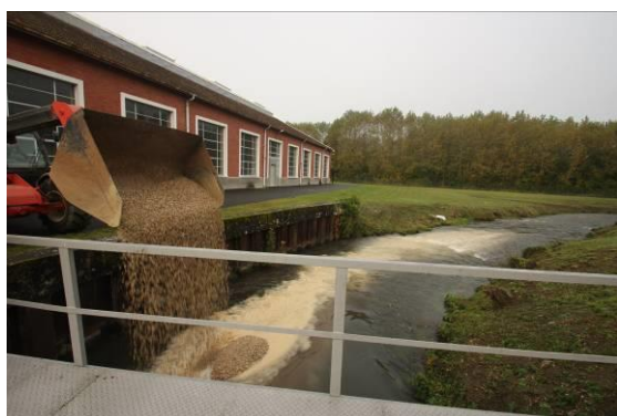
Photo 11 : Recharge granulométrique sur l'Automne
