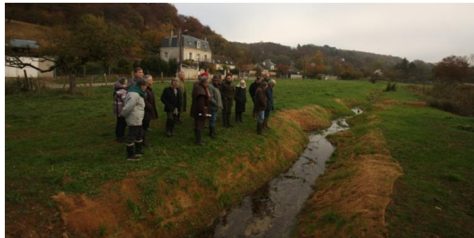
Photo 24: Journée sur les travaux en rivière
