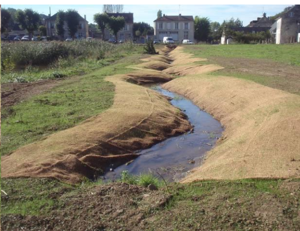
Photo 5: Ru de Bonneuil après travaux
