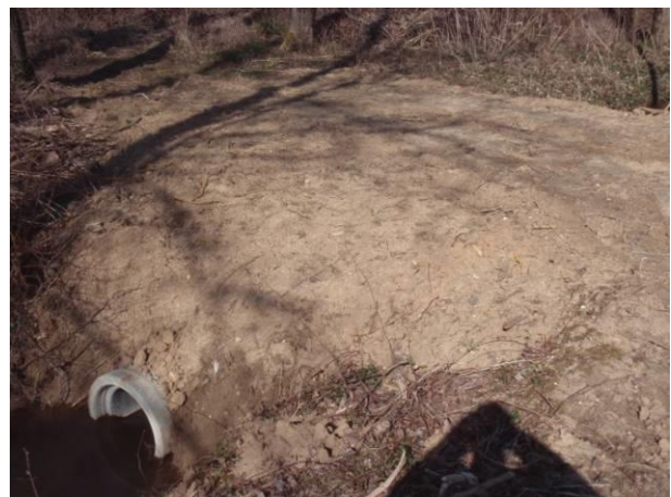
Photo 23: Buse sur le ru de Morcourt
