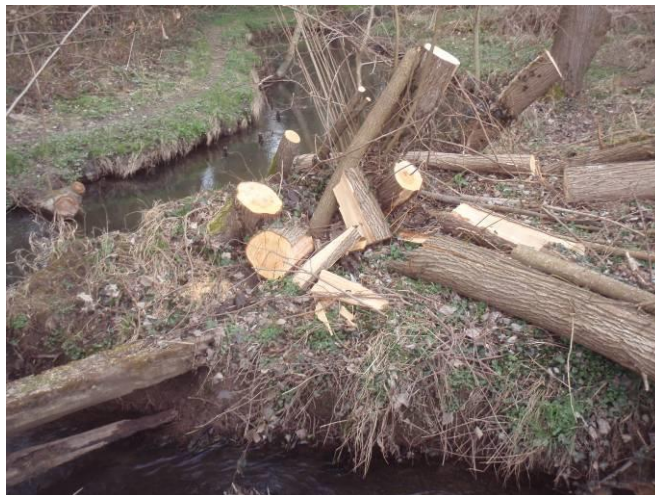
Photo 19: Abattage en cours sur le ru de Morcourt
