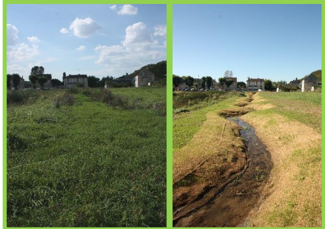
Le ru de Bonneuil avant et après restauration (resserrement du lit)
