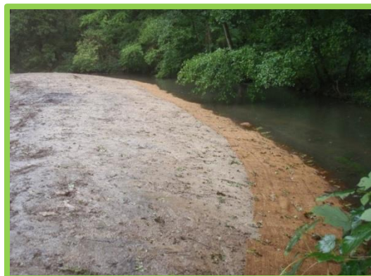
Berge talutée et protégée par un géotextile biodégradable
