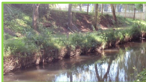
Fascine de saule réalisée sur l'Automne après un an
