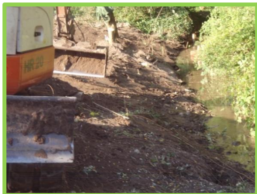
Talutage de berge en pente douce en cours
