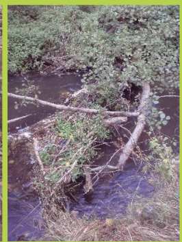
Embâcle à supprimer
