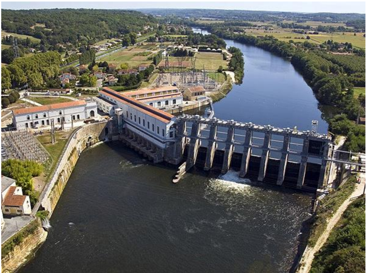
Unité hydroélectrique de production du Centre - EDF
