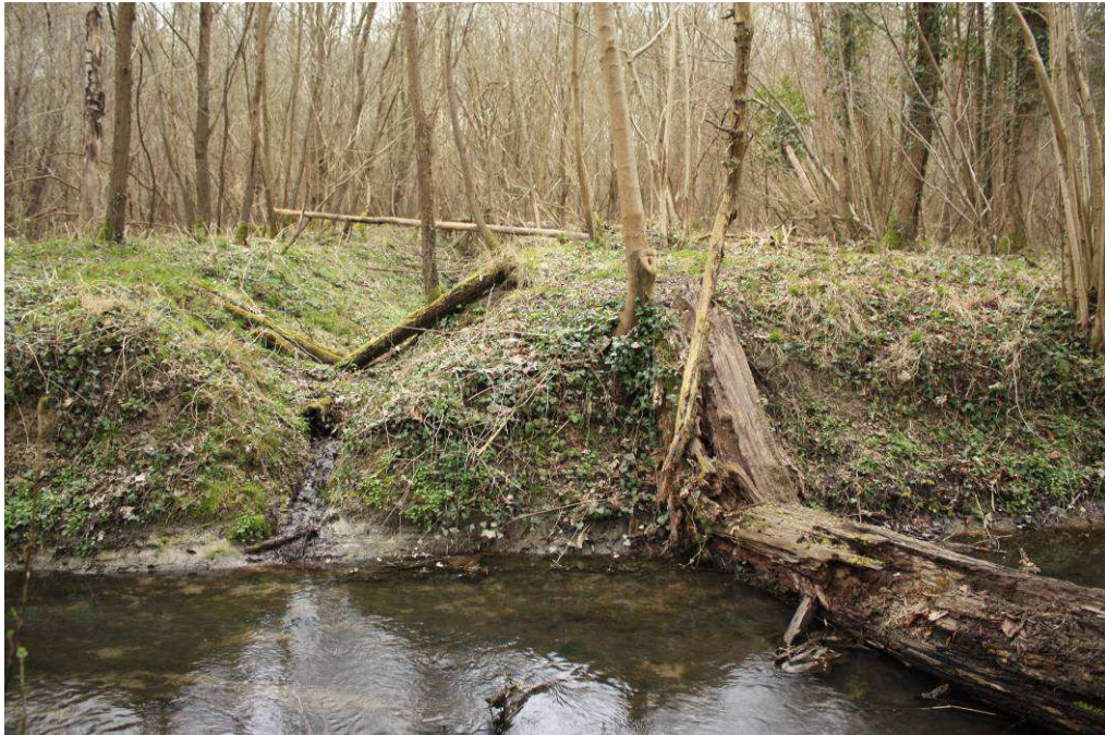
Figure 2-20 : Photographie du système de drainage d'une peupleraie (Source : SAFEGE)
