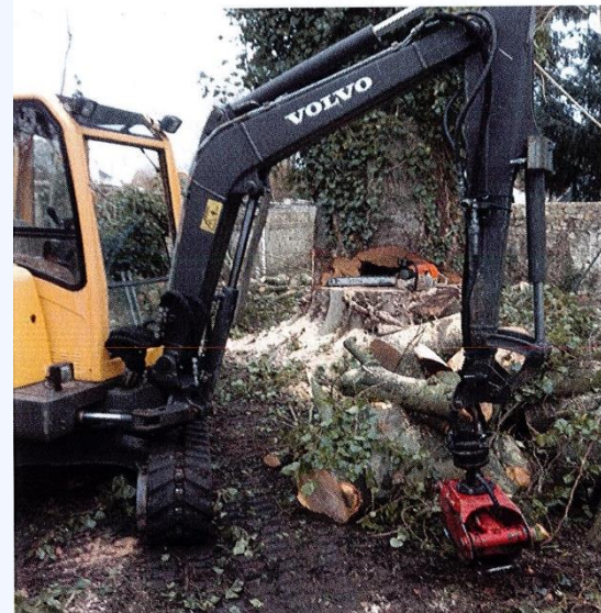
Pelle Hydraulique 2,5 Tonnes équipée d'un grappin :
