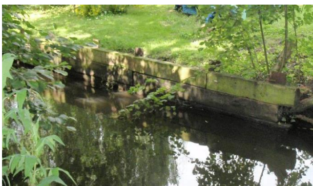
Photo 4 : Traverses de chemin de fer installées en berge
