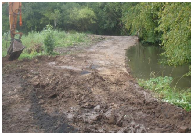
Photo 18 : Arasement du merlon et retalutage en pente douce
