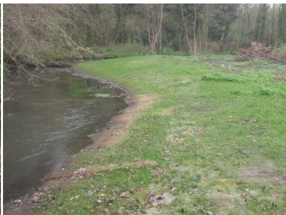
Photo 17 : Merlon arasé 2 mois après les travaux
