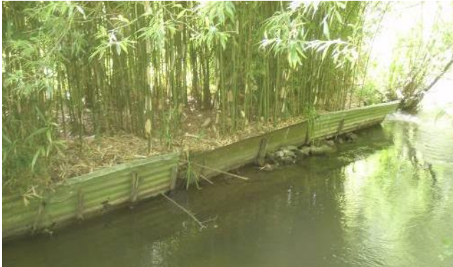
Photo 8 : Protections de berge en tôles et bambous
