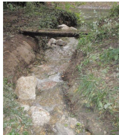
Photo 14 : Mise en place de blocs et recharge du ru Coulant - vue de l'amont
