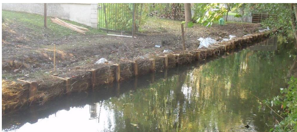
Photo 6 : Fascine de saule en cours de finition
