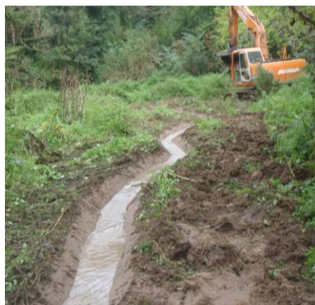
Photo 16 : Mise en eau du nouveau lit du ru des Cotillons
