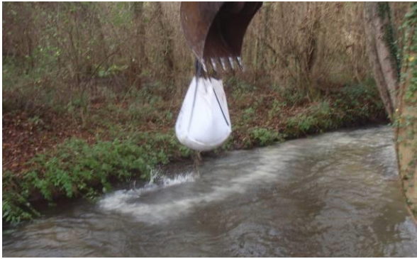
Photo 12 : Mise en place des graviers dans la Sainte-Marie
