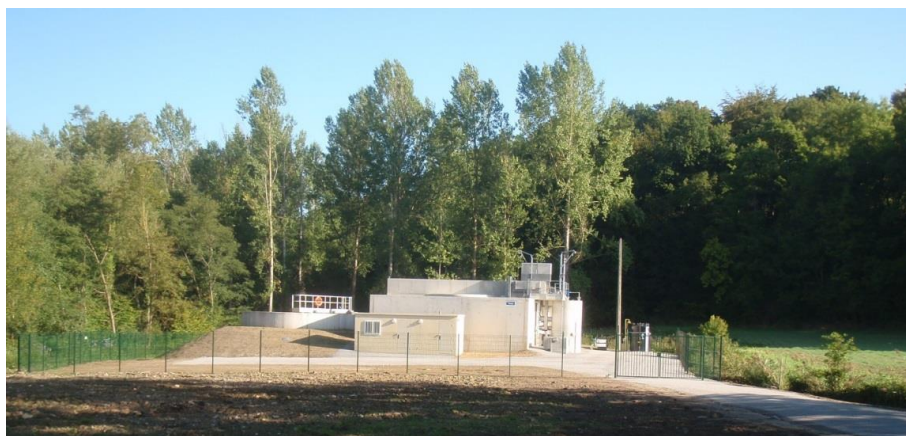
Photo 1 : Station d'épuration de Vaumoise terminée
